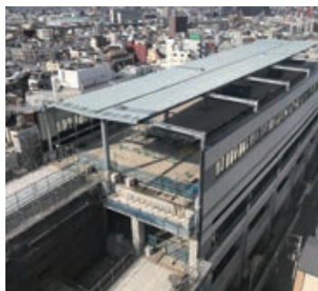
新淡路駅部工事
