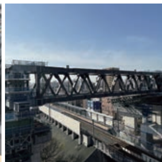
2層トラス桁架設工事
