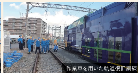
架線の復旧訓練
