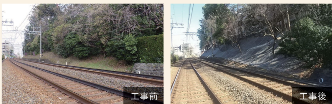
土砂崩れに対する防止工事の一例(斜面の崩壊や落石の防止)
